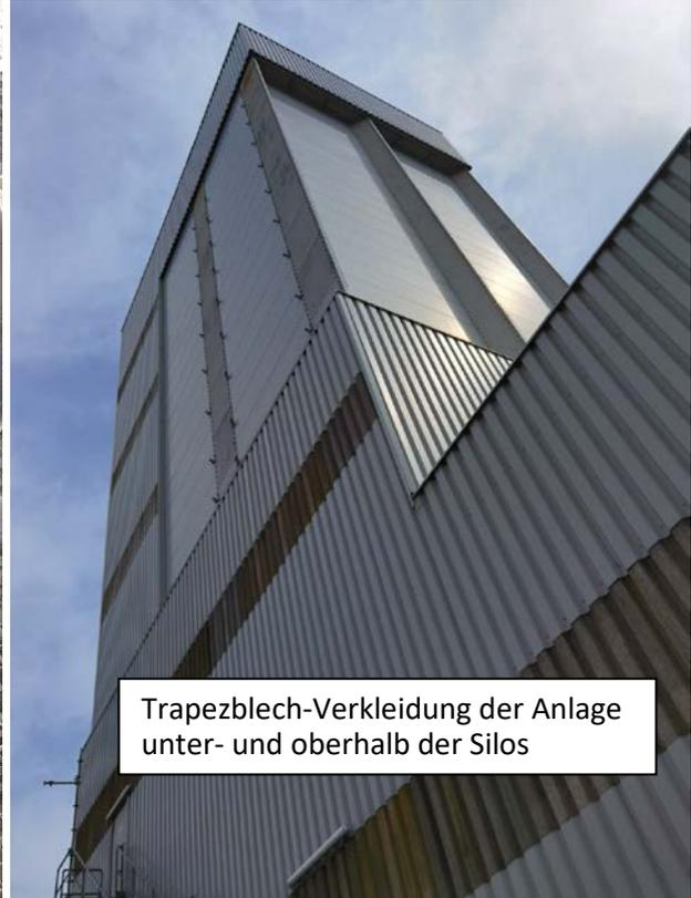
Trapezblech-Verkleidung der Anlage unter- und oberhalb der Silos
