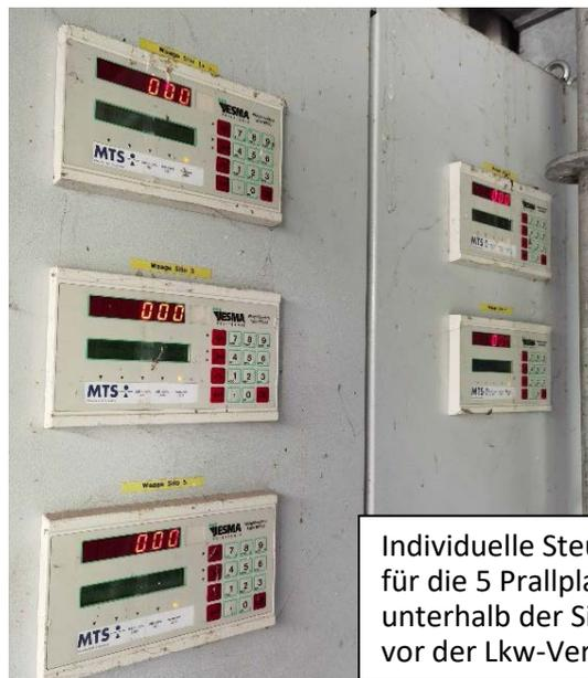
Individuelle Steuerungen für die 5 Prallplattenwaagen unterhalb der Siloausläufe vor der Lkw-Verladung
