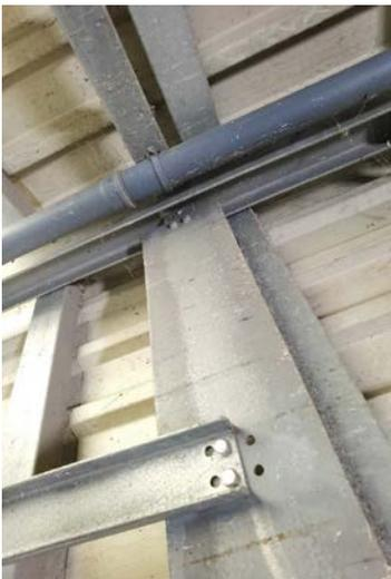
Die gesamte Stahlkonstruktion ist geschraubt und kann daher einfach demontiert und wieder montiert werden!
